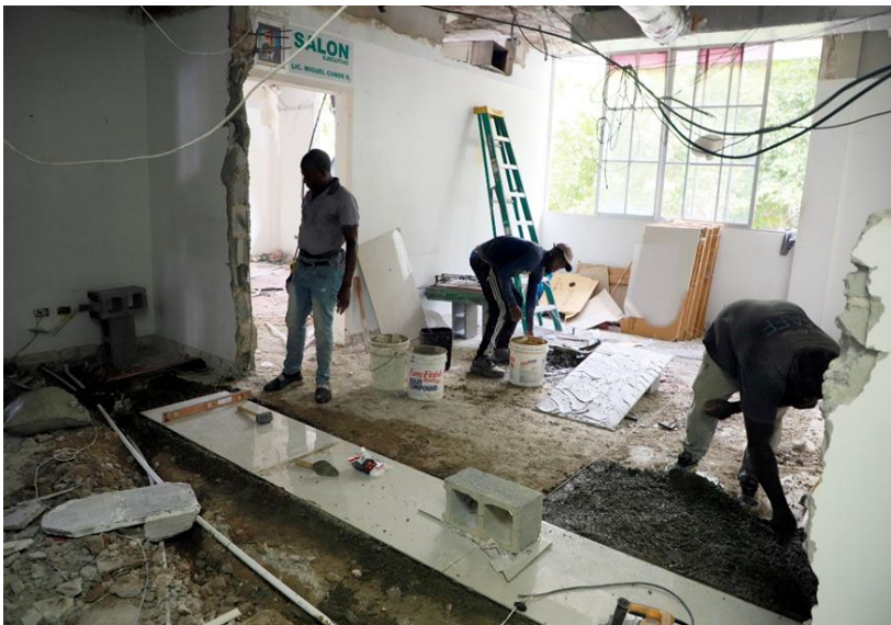
Foto 19. Remoción y adecuación de la recepción.
