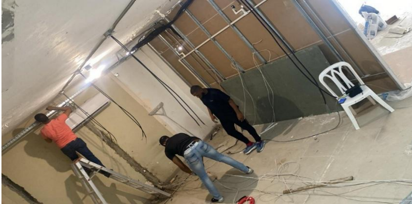
Foto 24. Instalación de cableado en la Dirección de Incorporación.
